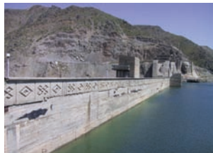
Resim 37: Kırgızistan- Talas'da Bir baraj
